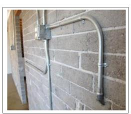
Fig. 3.1.2 GI conduits on a wall
